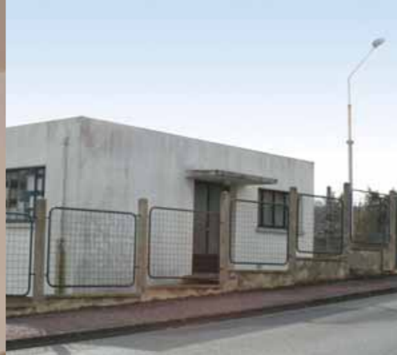
Entreprise Souriau, bâtiment d'accueil, rue Robert Surmont, début des années 1960.
