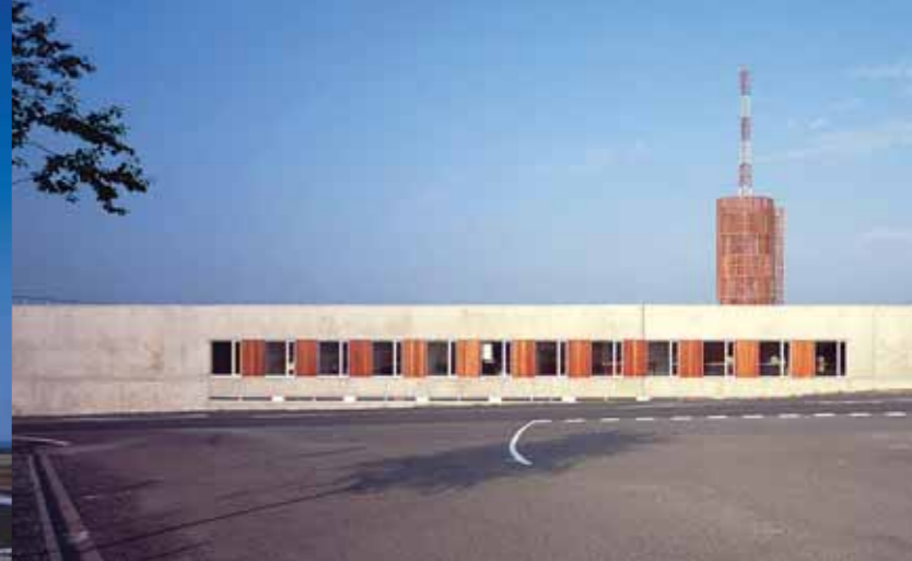
Centre de Secours. L'élévation donnant sur la route de Vibraye ; conçu en béton brut, le bâtiment a été peint peu de temps après sa construction.
