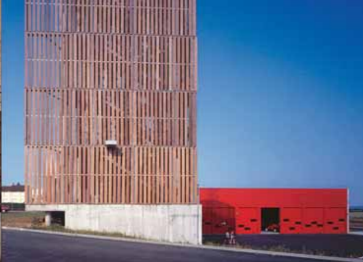
Centre de Secours, 2000 (Agence Barré-Lambot, Nantes). La tour de manœuvre et de séchage, et la remise à véhicules.
