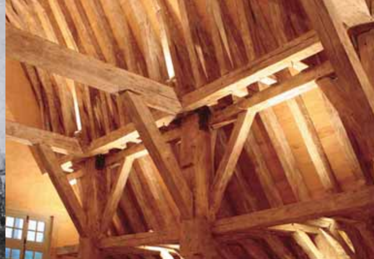
Charpente en chêne des halles, restaurée en 2006-2007.
