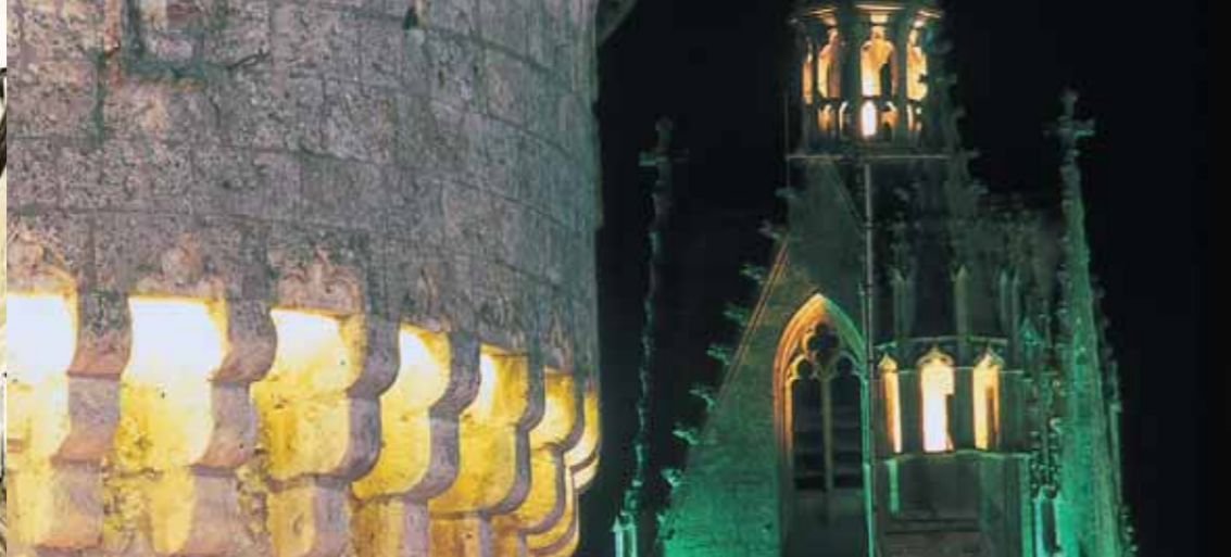
La porte Saint-Julien, détail des mâchicoulis et la tour-clocher de l'église Note-Dame-des-Marais.
