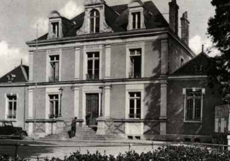
L'ancien presbytère construit en 1869 et utilisé en mairie depuis 1907.
