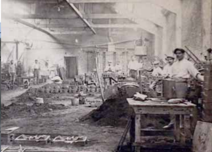
Site du couvent des Récollets, Fonderie Fatz, intérieur des bâtiments avec les ouvriers préparant les moules, première moitié du XX e siècle.
