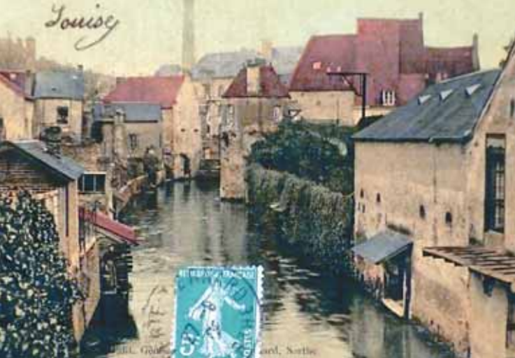
Vue de l'Huisne et du front est de la fortification depuis le pont de la rue Denfert Rochereau. A l'arrière-plan, la tour Lepelletier et les Grands Moulins.
