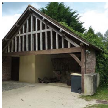
Lavaré, remise du prieuré
