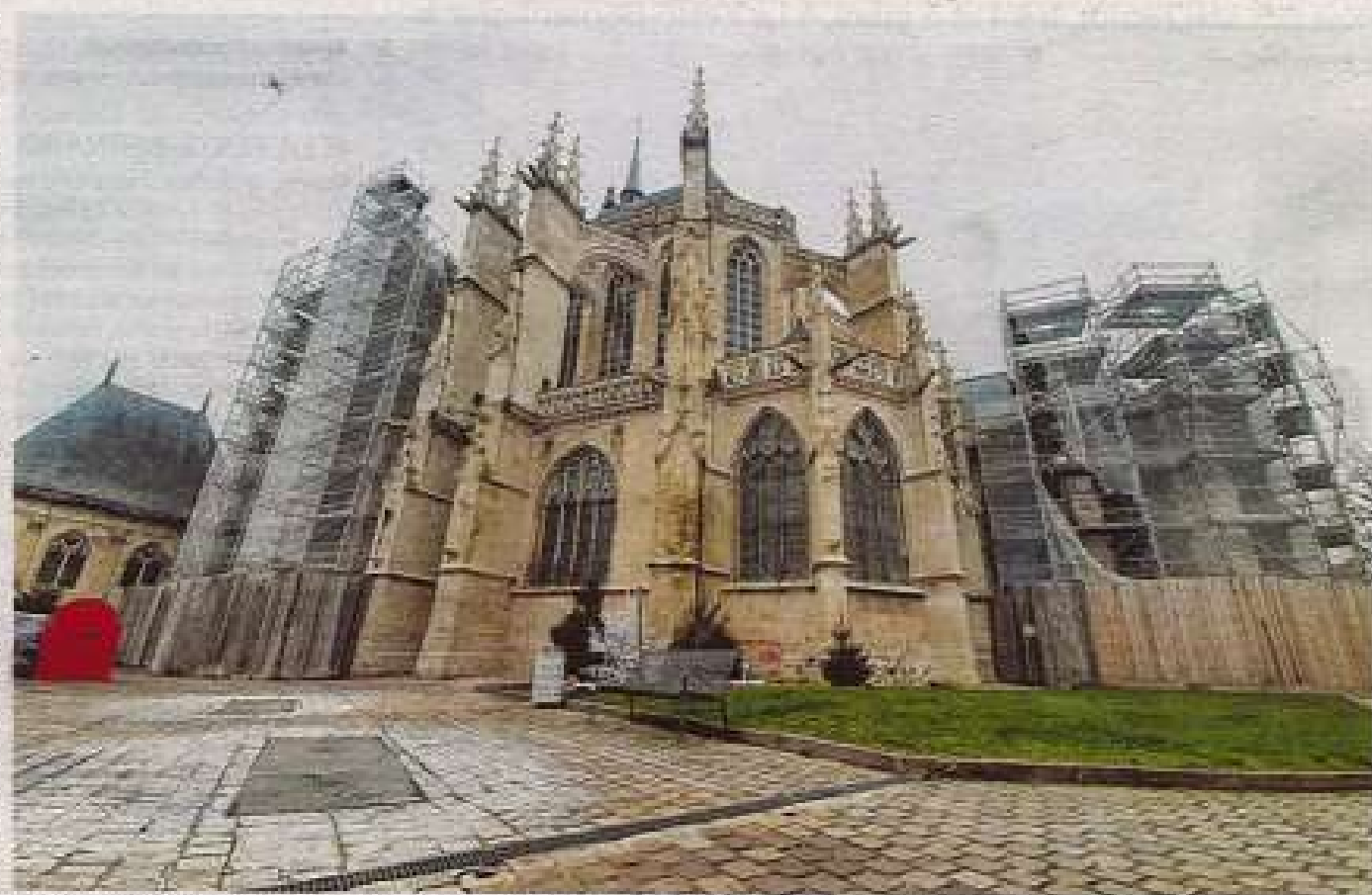
Une partie refaite, une partie échafaudée, c'est un bon résumé de la situation actuelle à l'église Notre-Dame-des-Marais.
