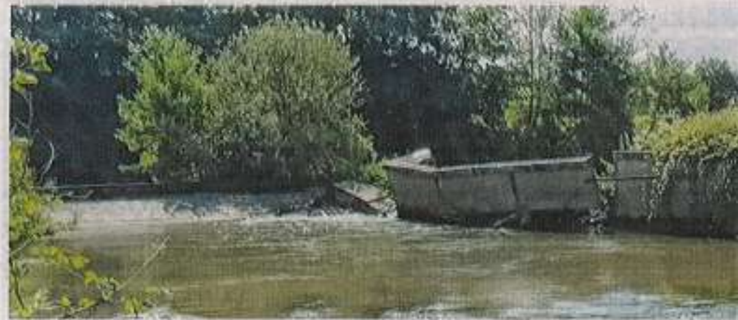
Le barrage de Quincampoix, situé entre La Ferté-Bernard et Saint-Martin-des-Monts, a été très endommagé par la tempête de 2009.
