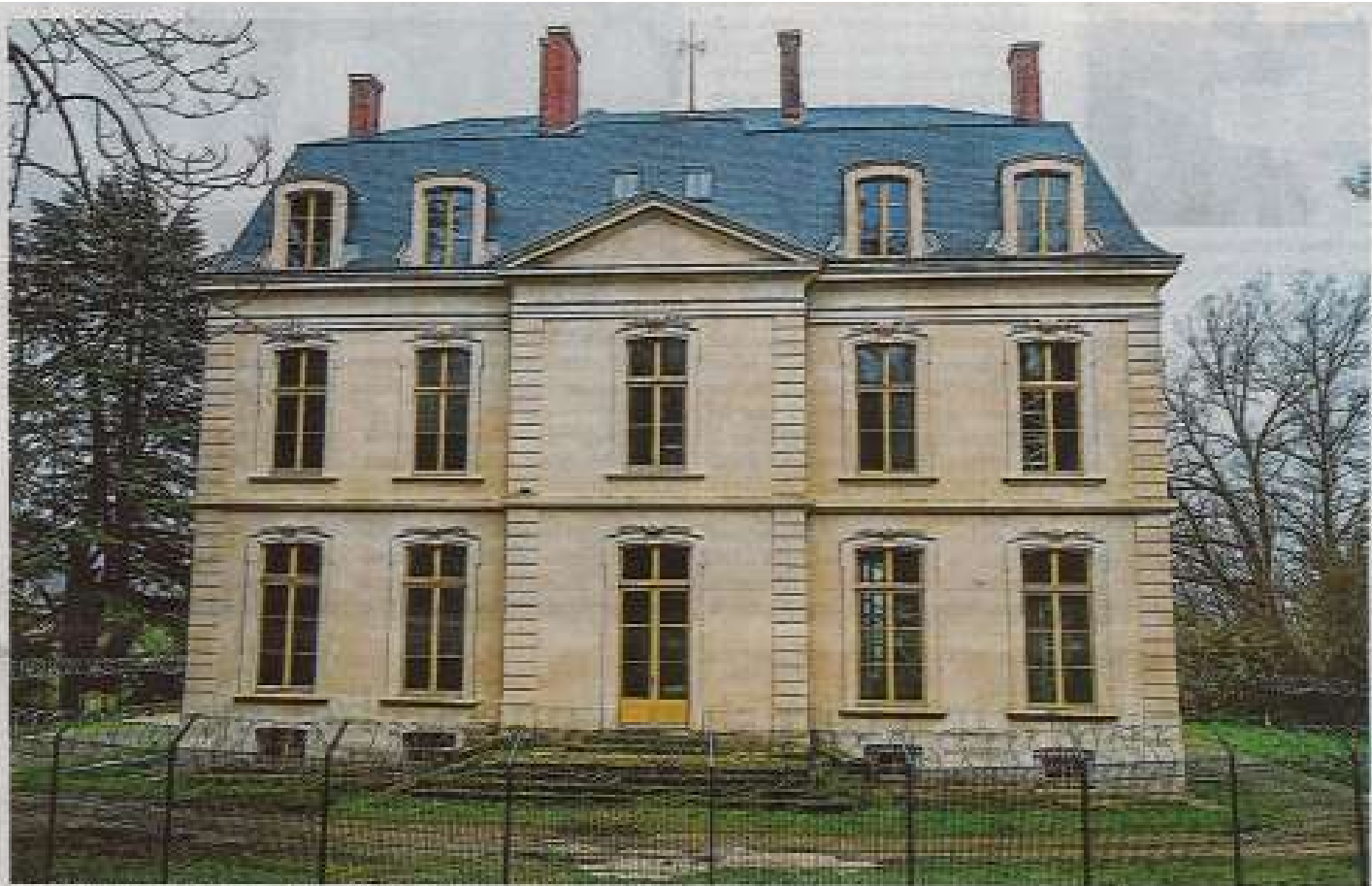
Le château du Haut-Buisson, entouré par des grillages et des barbelés pour protéger le chantier, a retrouvé un aspect magnifique. PHOTO : J. LEBLANC / P. LEBLANC
