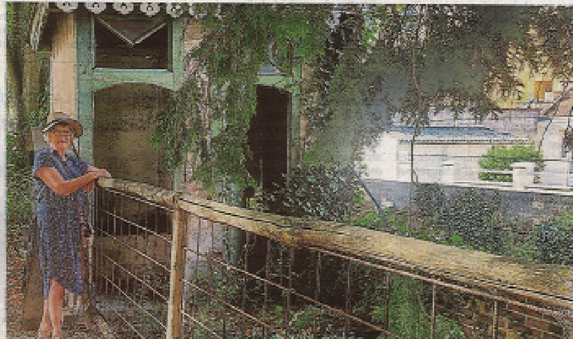
Nicole Prunier montre l'escalier descendant à la rivière où le lavoir n'existe plus. Les latrines, elles, tombent en ruines.
