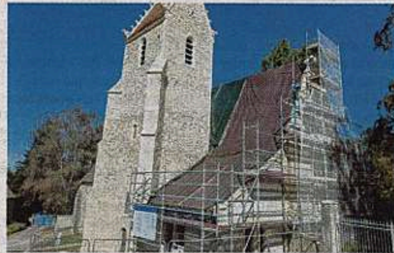
Les travaux avancent à vitesse grand V à l'église de Sceaux-sur-Huisne où une belle fête du patrimoine se prépare. Valentin MAUDUIT
